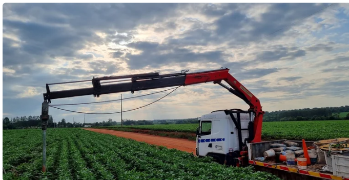
Camión grúa en tendido de línea.
